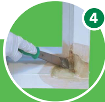
4 Hecht-/contactvlak aanbranden
