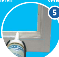
5 DRY SEAL™ aanbrengen
